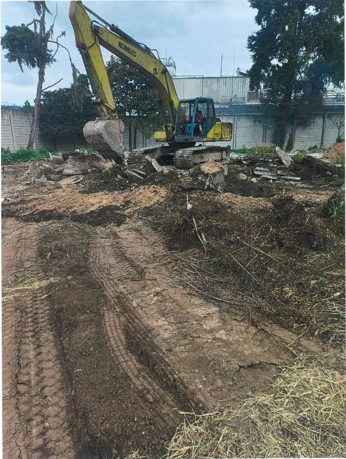
EXTRACCIÓN DE CIMIENTOS Y LIMPIEZA DE TERRENO
