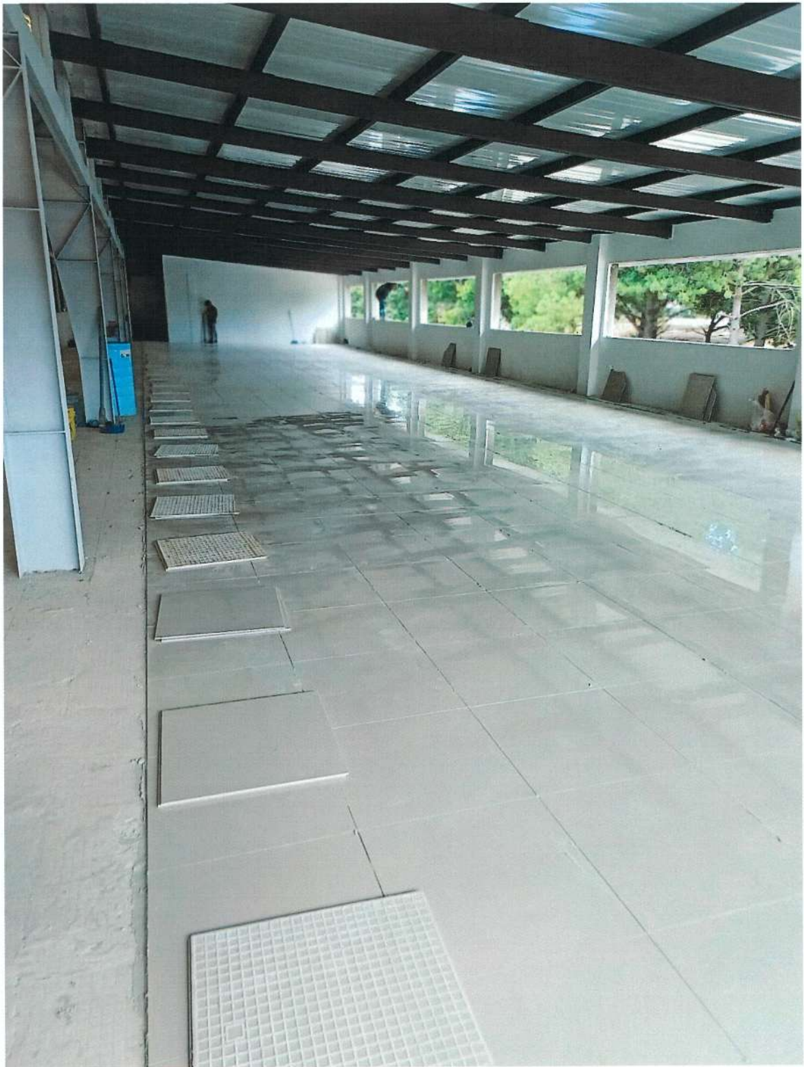
INSTALACIÓN DE PISO
