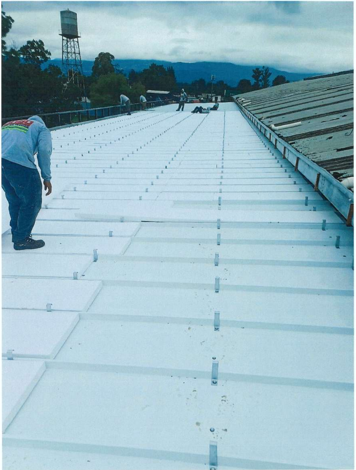
INSTALACIÓN DE CUBIERTA
