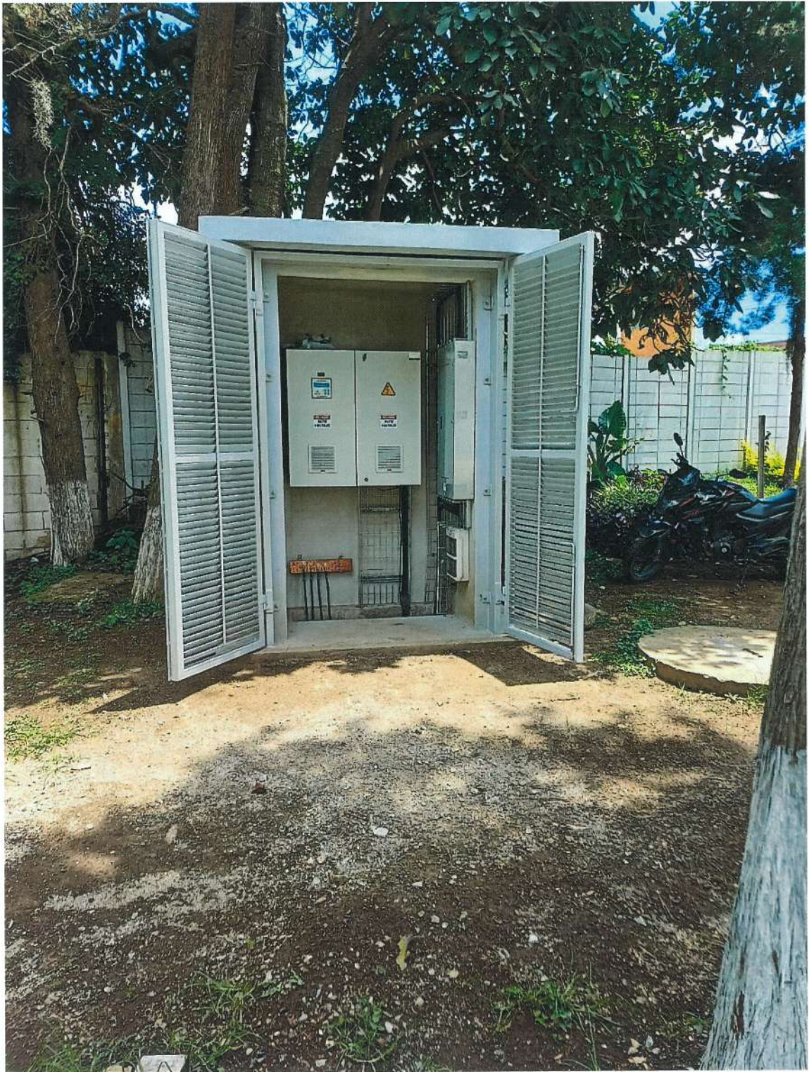
INSTALACIÓN PUERTAS TIPO LOUVER Y CUARTO ELECTRICO
